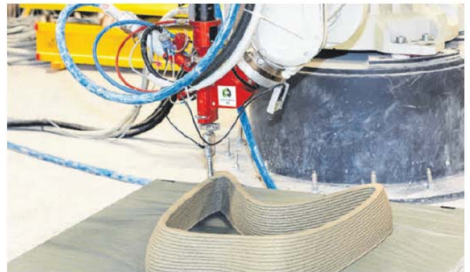
Hier wird gerade ein Betontisch gedruckt. Das dauert circa 15 Minuten.
