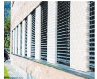
Die Fassadenelemente in Nenzing kommen ebenfalls aus dem Drucker.
